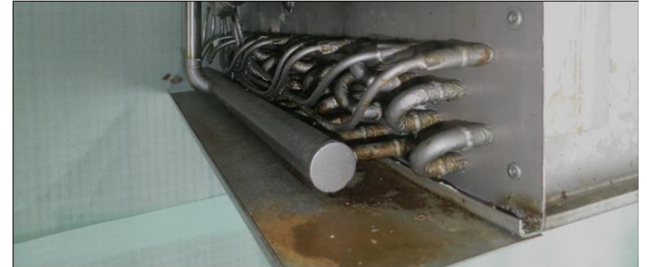
Bild 2: Schrägansicht des Rahmenblechs mit flächiger, brauner Belegung
